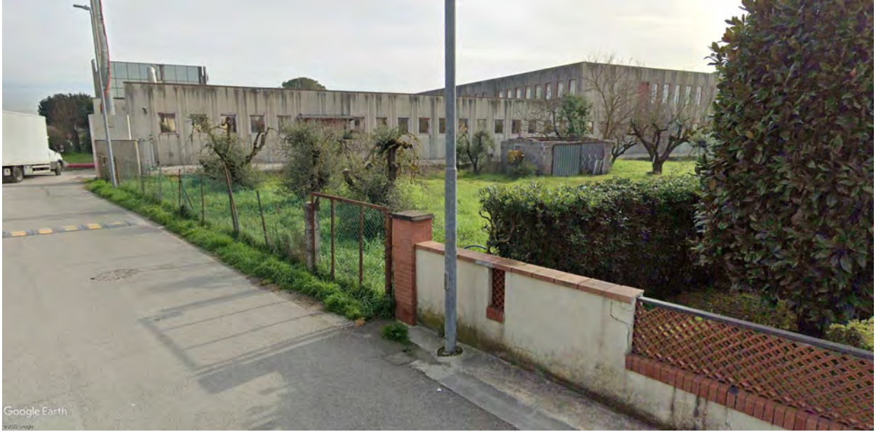
F3 - Vista nord-ovest, da via del Tiglio
